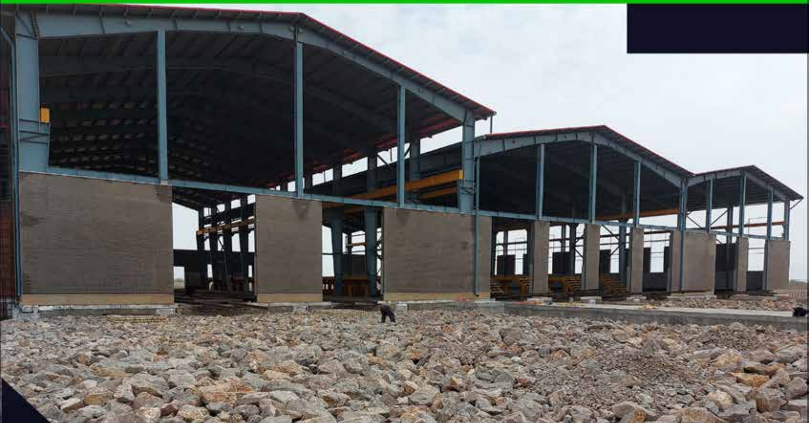
کارخانه در حال احداث در ایستگاه سیستان (اصفهان)
